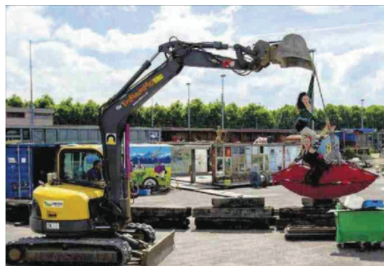
Die Bauarbeiten auf dem Gelände am Klybeckquai/Uferstrasse sind in vollem Gange
